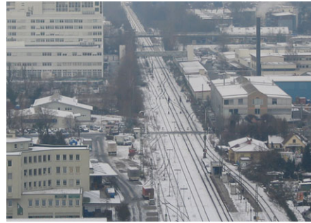
Blick von Ost auf Gleisflächen und Bahnhof
