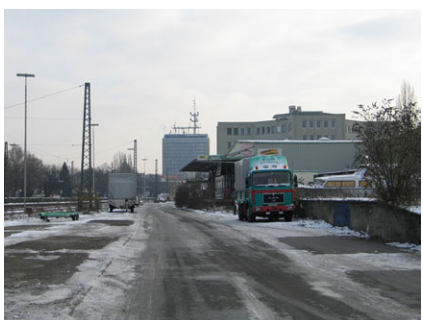
Flächen / Hallen südlich der Bahnlinie
